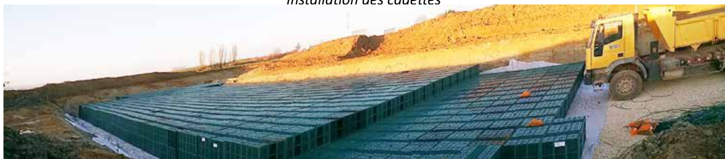
Installation des caquettes
