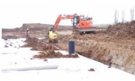
Remise en place de la terre végétale sur le bassin
